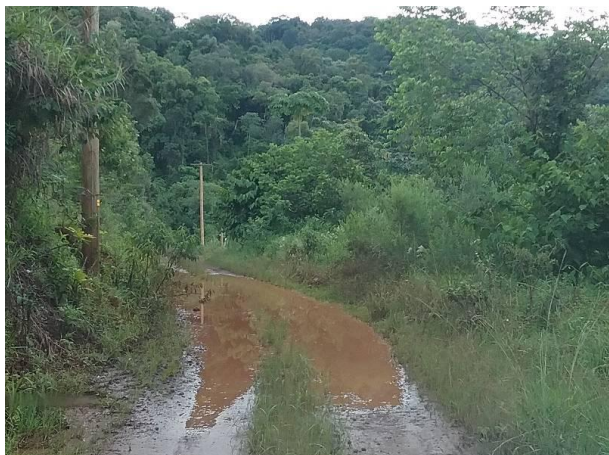
EMPOÇAMENTO DE AGUA NO ACESSO A TORRE (TULIPA) EXTRAVASOR DA BARRAGEM.
